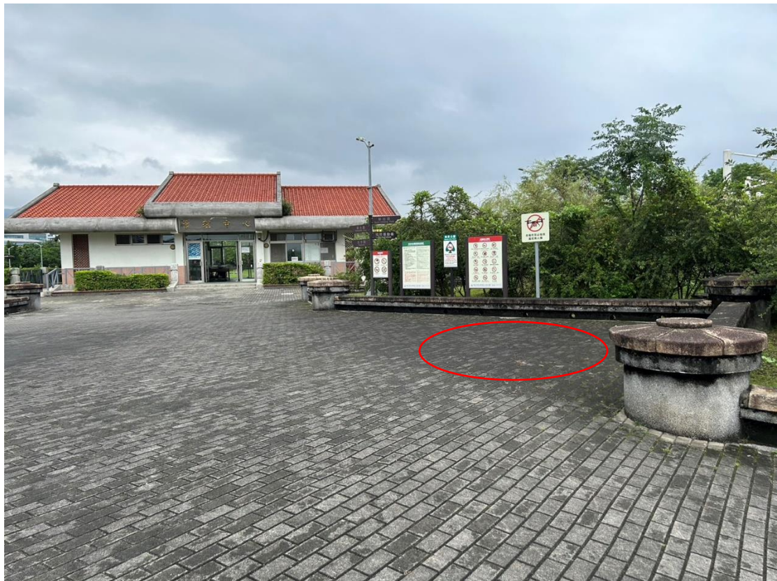
圖示2、內湖污水處理廠附設休閒運動公園「管理中心」(向正門面) 前之廣場紅色框選處
