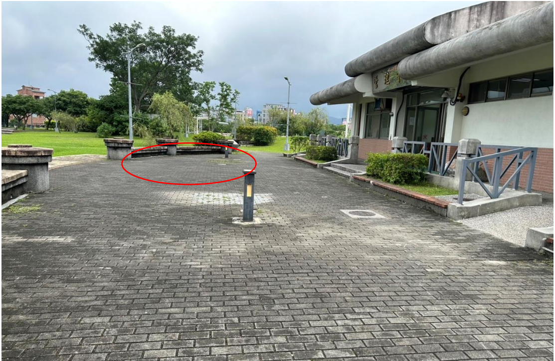
圖示1、內湖污水處理廠附設休閒運動公園「管理中心」(向草皮面) 前之廣場紅色框選處
