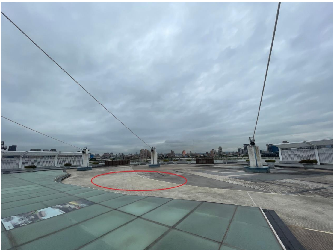
圖示6:迪化污水處理廠附設休閒運動公園「跨堤景觀平臺」紅色框選處
