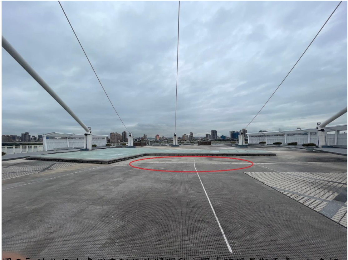
圖示5:迪化污水處理廠附設休閒運動公園「跨堤景觀平臺」紅色框選處
