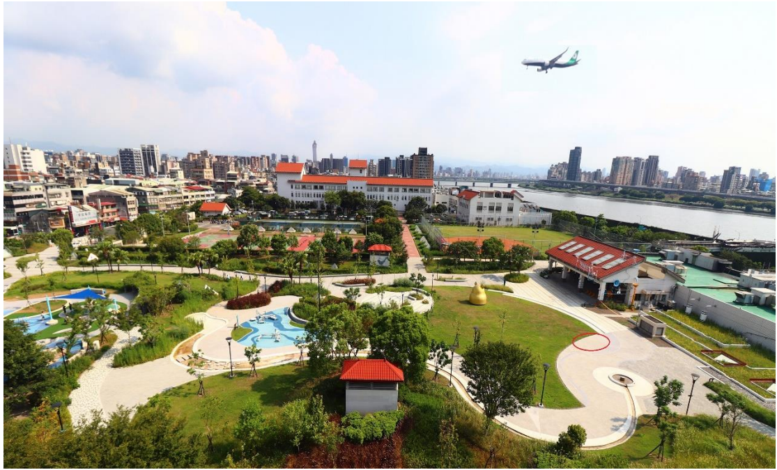
圖示3:迪化污水處理廠附設休閒運動公園「水道池」旁紅色框選處
